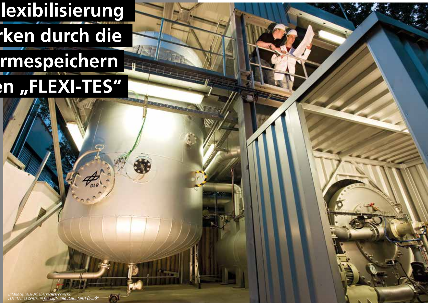
Bild: HOTREG – Technikumsanlage für Feststoffwärmespeicher am DLR in Stuttgart
