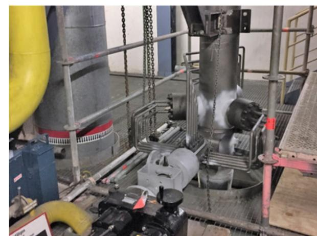
Bildunterschrift: Eingeschweißtes Dampfrohr mit integriertem Thermoschockrohr mit bereits installiertem Steuerteil und Rohrbündel. Quelle: TEC artec
